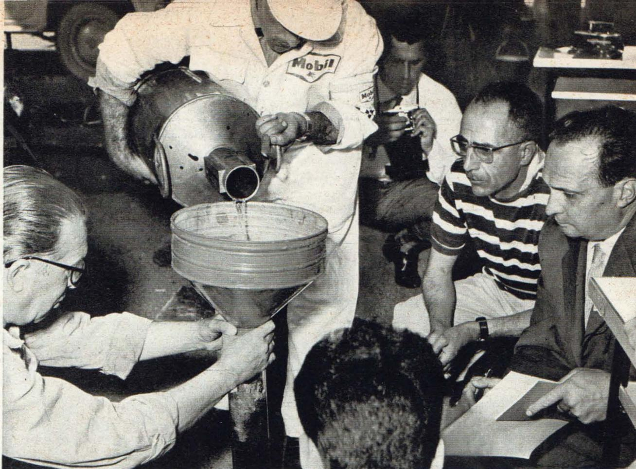
*Sous les yeux attentifs des contrôleurs et d'un concurrent, on mesure dans une éprouvette géante ce qui reste d'essence dans le réservoir à l'arrivée*
